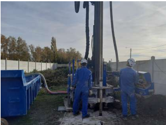
Foration avec tête rotary Ø311 mm à injection d'eau
